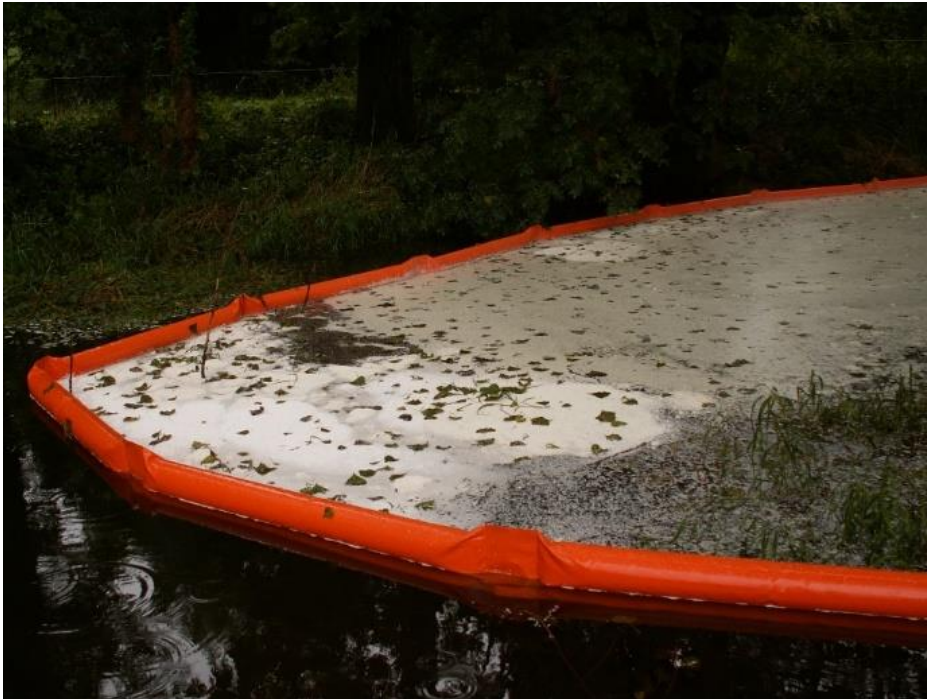
Abbildung 10: Einsatz von schwimmfähigem Ölbindemittel bei Ufervegetation (©THW Borna)
