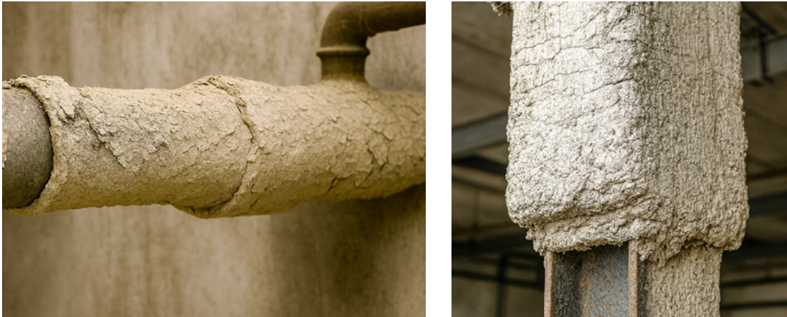
Abbildung 10: Asbesthaltige Rohr- bzw. Stahlträgerisolation (Fotos: © MS Copilot)
