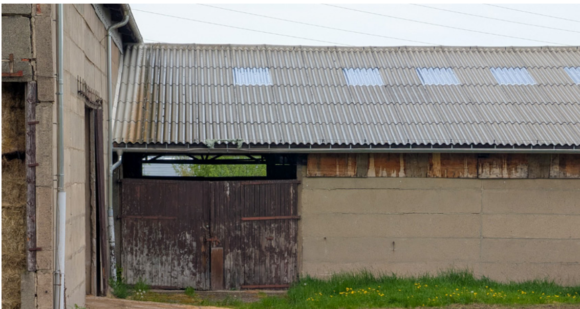
Abbildung 7: Asbesthaltige Dacheindeckung an Stallgebäuden (Foto: © S. Hennings)
